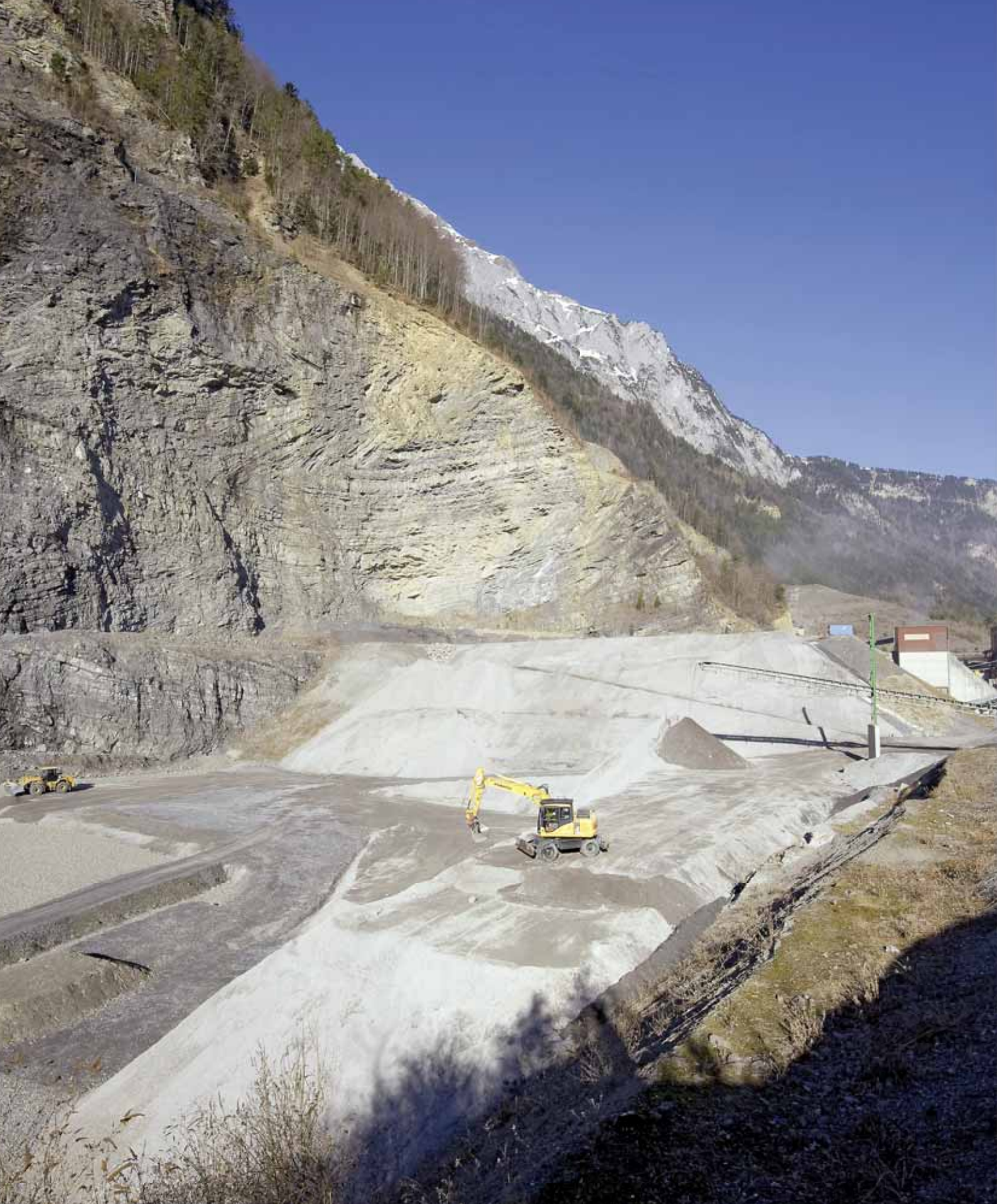
Die Deponie heute: Sicht auf Deponie-Etappe II und III. Im Einsatz die Baumaschinen der ZAKU AG beim schichtweisen Einbau von Schlacke.
