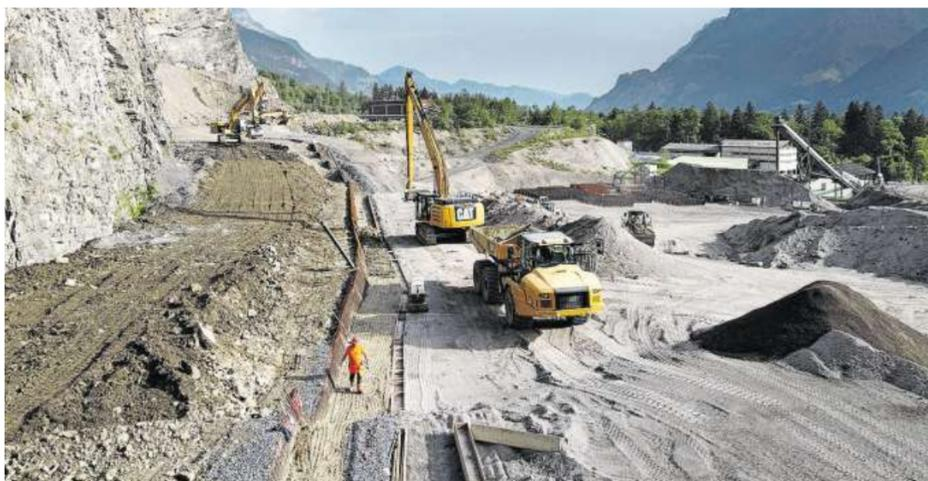
Die Zaku arbeitet an der Randabdichtung West: die Tonabdichtung (in der Mitte); der Einbau von Schlacke (rechts davon); sowie die Hinterfüllung gegen die Felswand (links davon). Bild: PD
